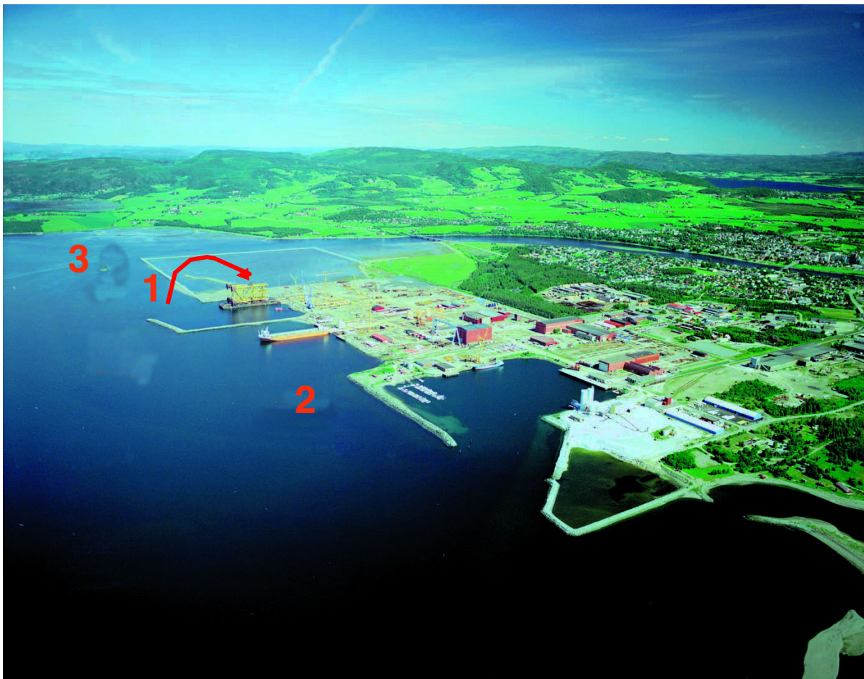
Figur 1. De tre tiltakene plassert omtrentlig i forhold til Verdalsøras sentrum. Tiltak 1: Mudring av marin masse for oppfylling av industriområde (pil); Tiltak 2: Mudring av dypvannskai med oppfylling i nærliggende område; og Tiltak 3: Privat masseuttak.
